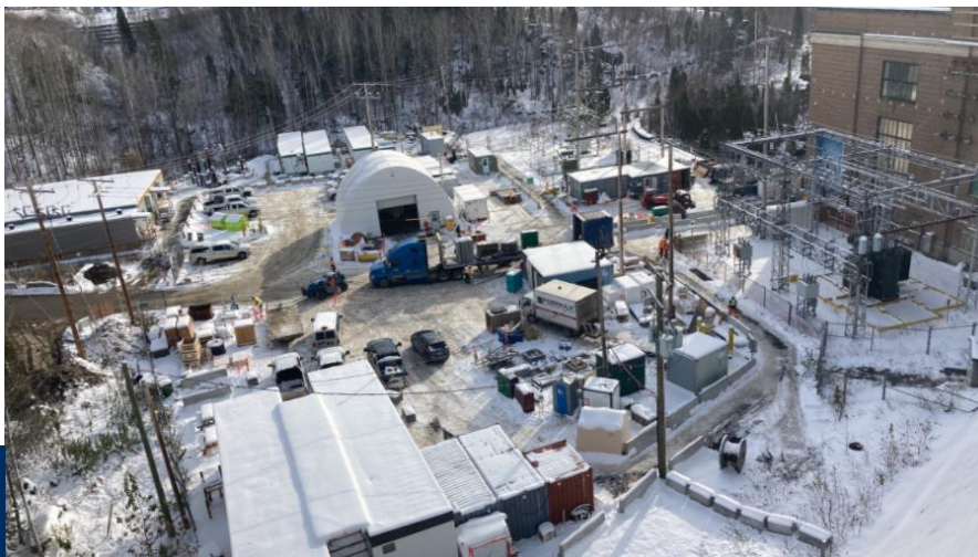
Aménagement chantier et poste 26 kV
