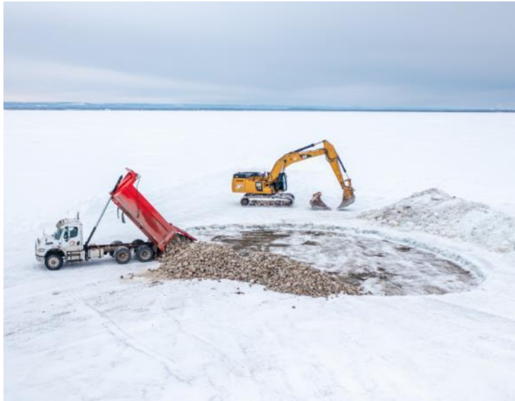
Aménagement de frayères de la CLAP : un travail de collaboration
