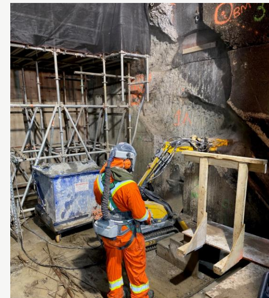
Démolition d'un cadre d'une vanne papillon
