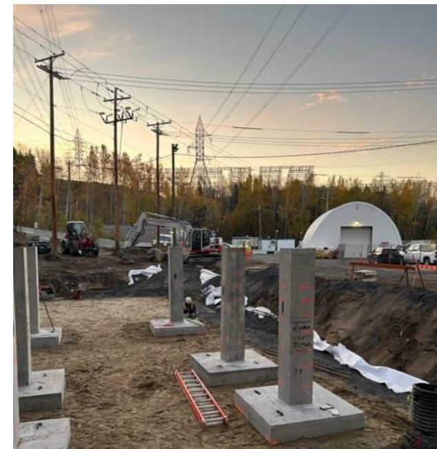
Les bases de béton qui supporteront la nouvelle station électrique du poste 26 kV déplacé.
