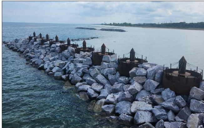
Exemple de structures de nidification pour la faune aviaire incorporées à la crête d'un brise-lame
